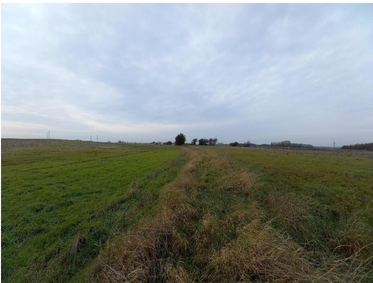
Billedet viser det eksisterende dige set mod vest.
