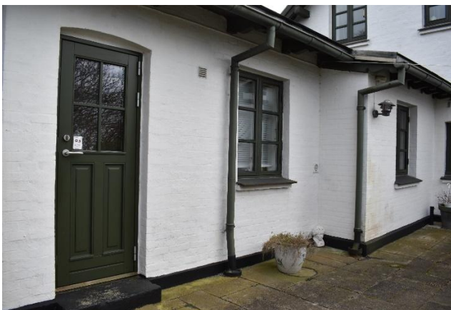
Tilbygning, nordlig side fra nordøst
