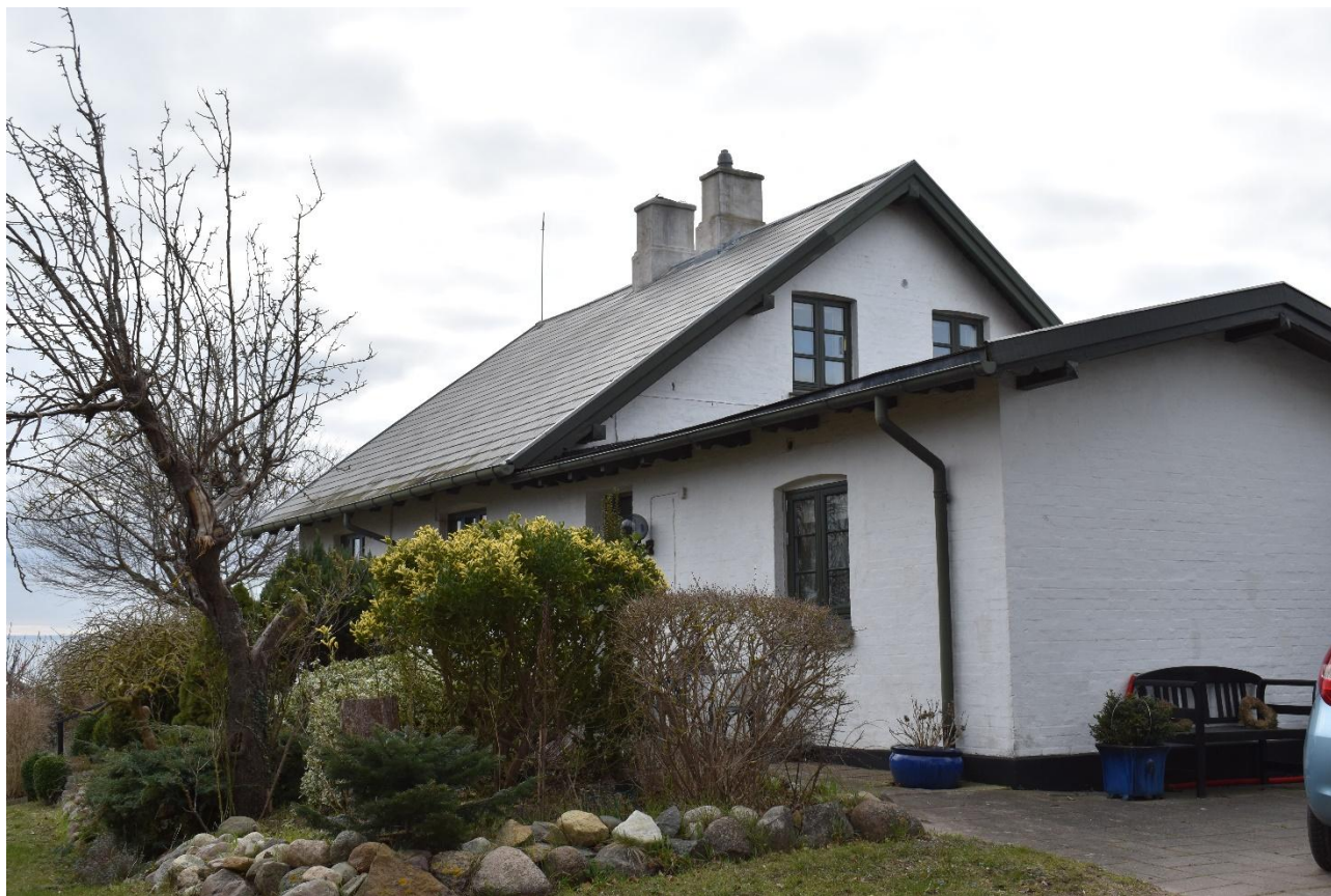
Tilbygning til villa, set fra sydøst
