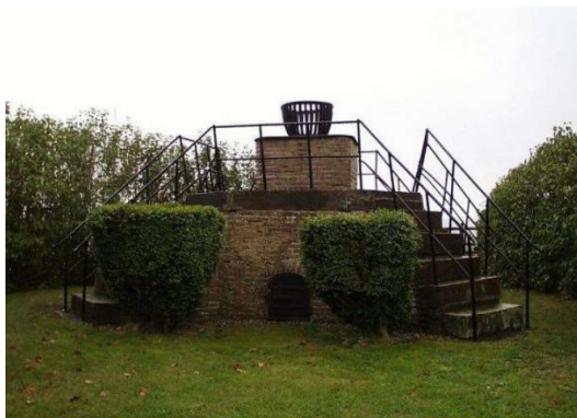
Foto af kulfyret, fra før det overdækkes.
