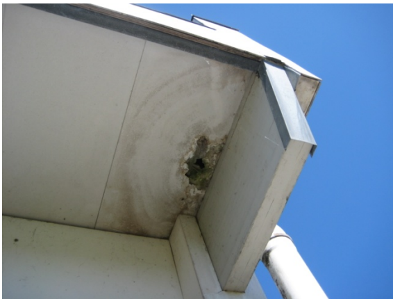
Dette arbejde er udført.
