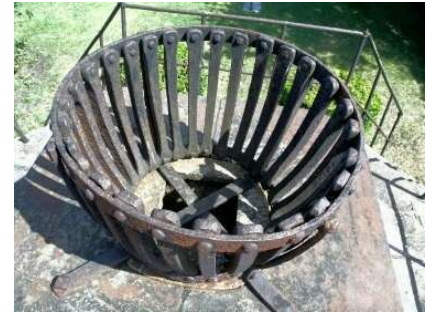
Jernkurven er placeret oven på den murede pille, som er afdækket af en stor jernplade (Ole Lemvig 2006).
