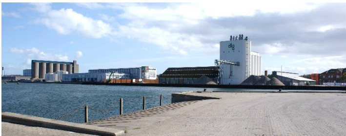
Den eksisterende "DLG" silobygning; her set i sammenhæng med den øvrige bebyggelse ud mod havnefronten.
