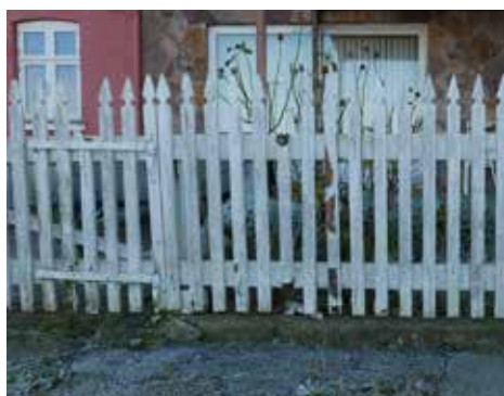
Sylovsvej: Tremmestakit med spidsede toppe på stavene.
