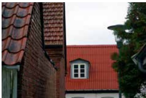
Forskellige typer tagdækning på huse i fiskergade: Tættest på røde vingeteglsten, i midten falstagsten med profilering og længst væk i billedet røde metalplader. Den nye lokalplan giver ikke mulighed for metalplader som tagdækningsmateriale.
