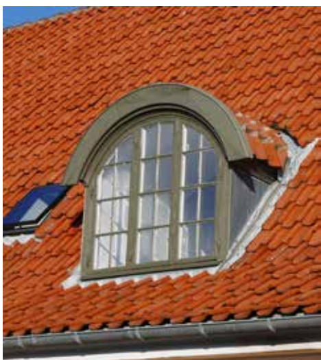
Heltagskvist med tøndehvælvet tag. Til venstre for kvisten ses et moderne, 6-stens tagvindue.
