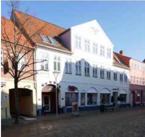
Forhuset Algade 50 er i 2 etager med udnyttet tagetage. Facaden rummer typiske klassicistiske træk: Stram fagdeling, symmetri, trekantfronton, korspostdelte vinduer med lige overkanter mm.
