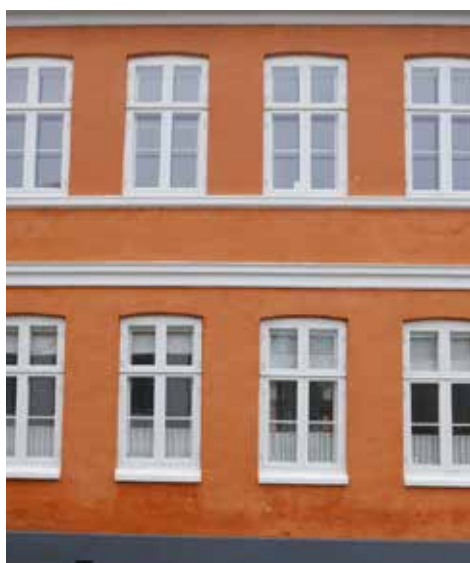
Forhuse Algade 18 har en klassicistisk facade med taktfast fagdeling og vinduesplacering. Bygningen er fredet.
