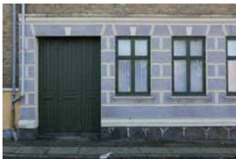
Algade 11: Forhusets stueetage er i facaden udført med kvaderstenspuds.
