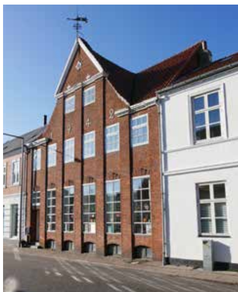
Forhuset Brogade 2 er opført i 1942 i samarbejde med foreningen (eller rettere bevægelsen) Bedre Byggeskik.
