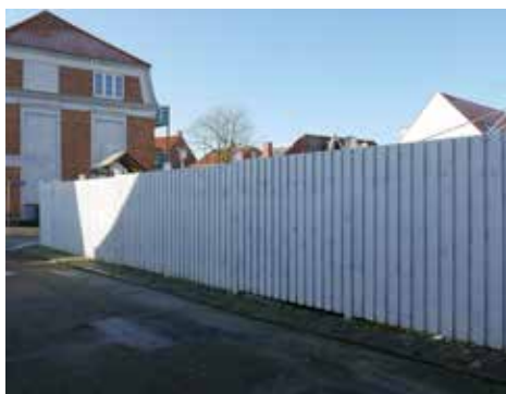
Kirkestræde: Plankeværk udført med beklædning "1 på 2".
