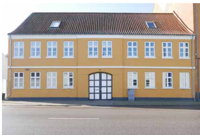
Batterivej 1: Et stort, klassicistisk forhus med symmetrisk facadeopdeling og taktfast vinduesplacering. Den store tagflade over gadefacaden er dækket af røde teglsten. Tagfladen brydes af to tagvinduer – et forhold som generelt helst set undgået i fremtiden.
