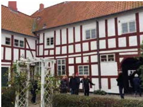
På forhuset Slottensgade 9 er facaden mod gården bevaret i bindingsværk, mens facaden mod gaden blev "moderniseret" og opført i grundmur i 1850'erne. Foto: Hans Jørn Andersen
