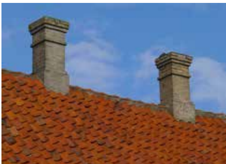
Ældre skorstene i traditionel udformning med sokkel, skaft og udkræning/gesims.
