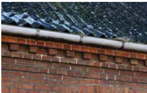
Muret hovedgesims med tandsnitsprofilering.
