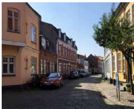
En tur gennem Slottensgade giver indtryk af den store variation i bymidtens bebyggelse. Her ligger bevaringsværdige etageejendomme side om side med mere anonyme byhuse i 1 etage.
