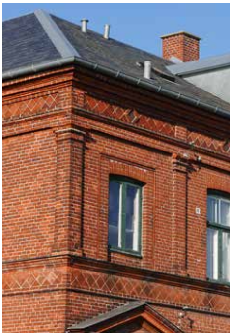
Detalje fra Kirkepladsen 12-14, Dommerkontoret, opført 1885. I facadernes blanke murværk ses murstenens mange variationsmuligheder, f.eks. relief (søjlemotiv) dekorative bånd samt formsten i portaler og gesimser.
