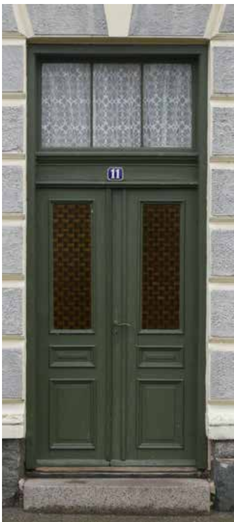
Tofløjet fyldningsdør med overvindue.
