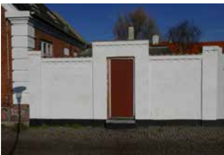
Rosenstræde: Pudset/malet hegnsmur med afdækning af vingeteglsten og med indgang til gård/have. Hegnsmuren opleves som en del af den sluttede randbebyggelse.
