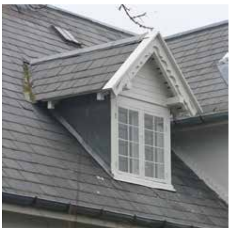
Heltagskvist med tagudhæng og udskårne udhængsspær (schweizerkvist).
