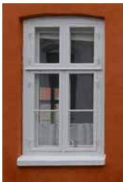
Klassicistiske korspostvinduer. De nederste rammer er opdelt med en smal sprosse, så alle ruder er lige store.
