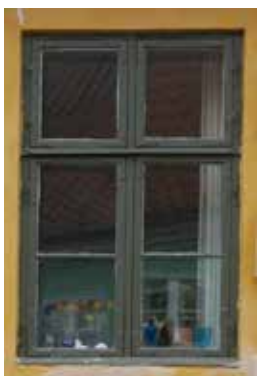
Klassicistiske korspostvinduer. De nederste rammer er opdelt med en smal sprosse, så alle ruder er lige store.
