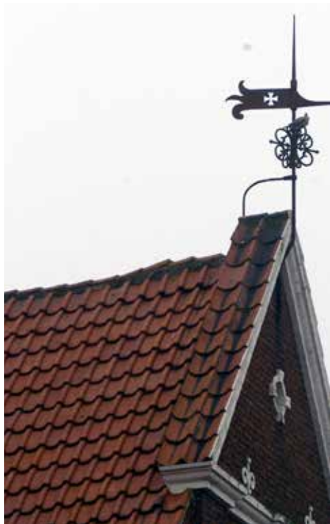
Gavlkam med vingeteglsten og tagflade med falstagsten.
