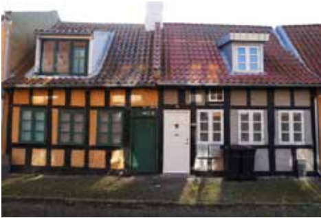
Kirkestræde 3-5: To små byhuse i 4 fag og med bindingsværk fra 1600-tallet. Husene er moderniseret og har blandt andet fået kviste.
