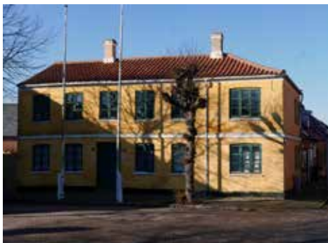
Kirkepladsen 7 er et grundmuret hus i klassicistisk stil. Åbninger i ydermurene til døre og vinduer er udført som huller i muren og placeret regelmæssigt i en fast fagdeling – altid adskilt af murpiller og i en begrænset højde og bredde.
