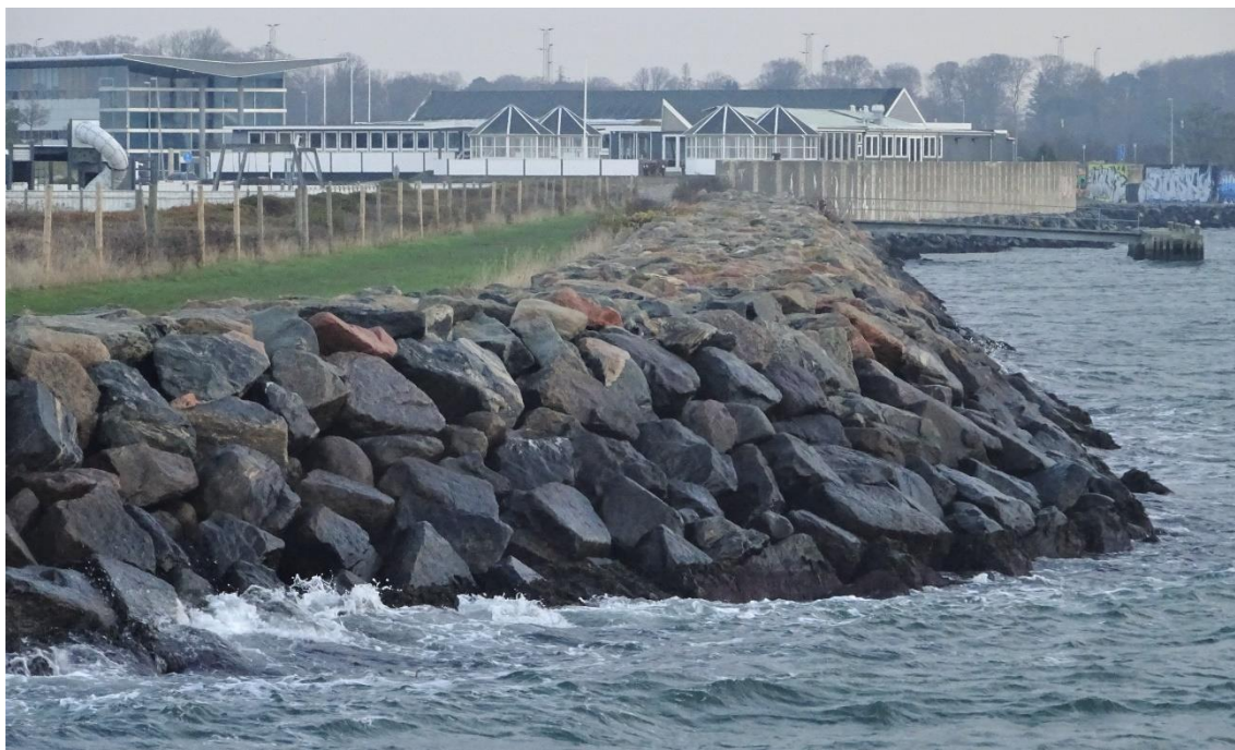
Figur 11: Eksempel på eksist. stenkastning fra inderhavnen i Halsskov, ind mod campingpladsen.
