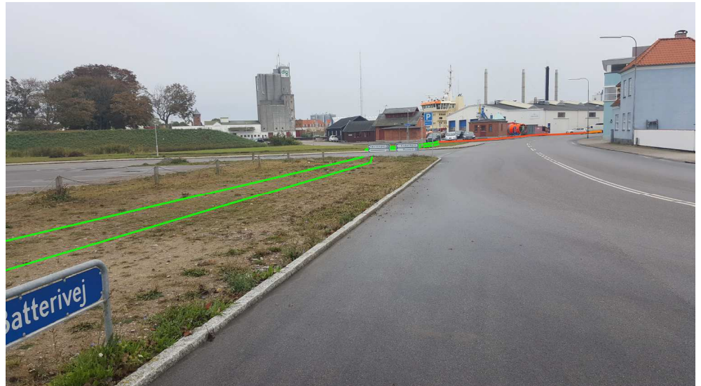
Figur 4-21 Skitseret linjeføring v. Sylowsvej/Batterivej. Jorddige. (Strækning E-F).
