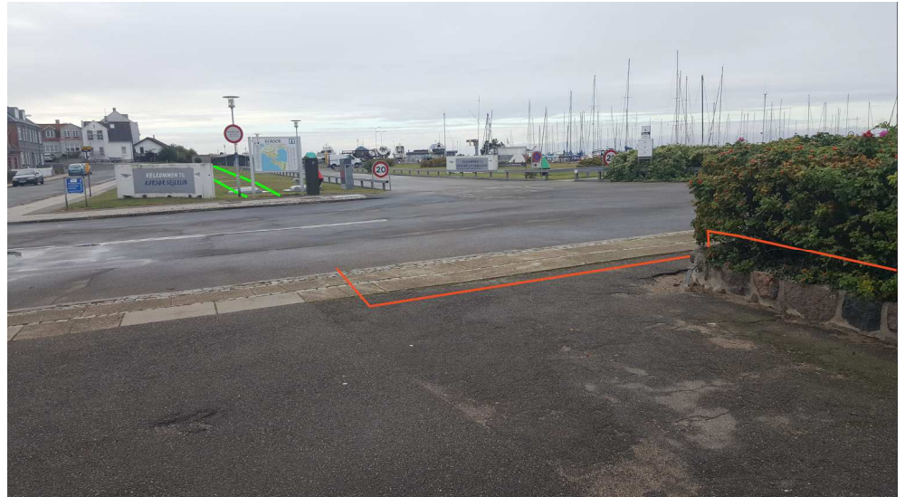
Figur 4-29 Skitseret linjeføring v. lystbådehavnen. Højvandsmur samt overgang til jorddige på grønt areal. (Strækning L-M).
