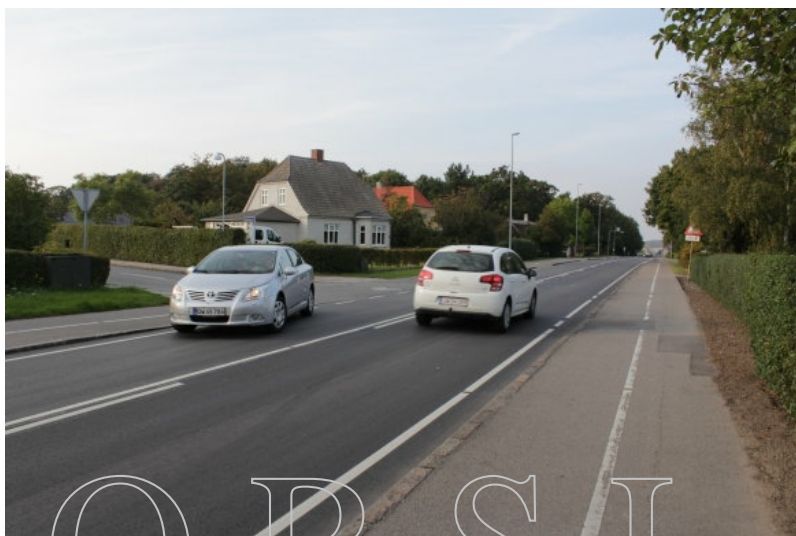
Slagelsevej ved Holmevej set mod nord.
