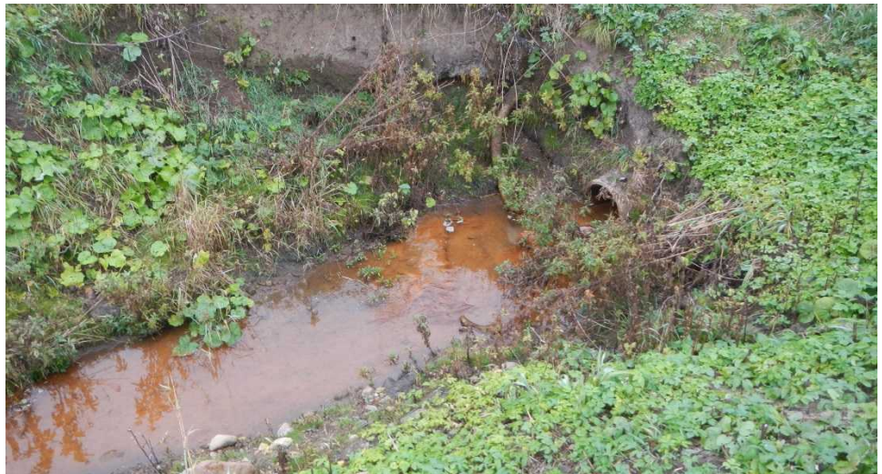
Figur 2-1: Udløbet af hoveddrænet i tilløbet til Harrested Å. Vandet var ved besigtigelsen tydeligt påvirket af okker. 03-11-2015.
