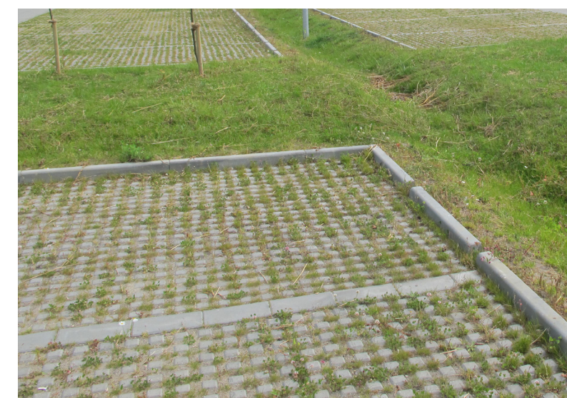
Græsarmeret parkering med flisestriber, obs. plastikasser i stedet for beton
