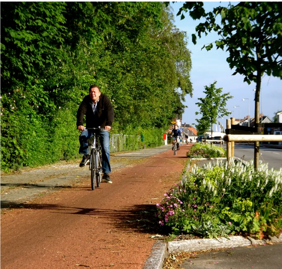
Den nye generation af farvede cykelstier i Nakskov - med OB overflade. En brugerundersøgelse fra 2019 viser stor tilfredshed hos slutbrugerne.
