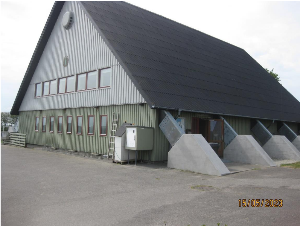
Hallens bølgeeternittag fremstår i generelt pæn stand (renset og malet i ca. 2015)
