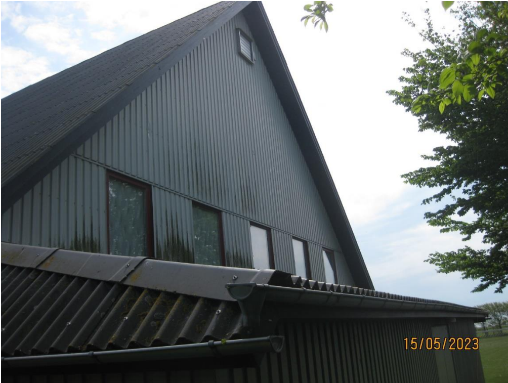
Facadebeklædning mod nord er tilsmudset af algebegrøning.
