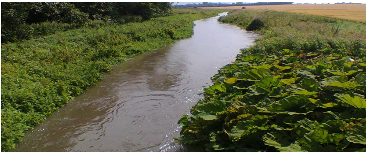
Skidenrenden 20170730 – overløb ved skybrud -Urenset spildevand og overfladevand. -Bemærk farven.
