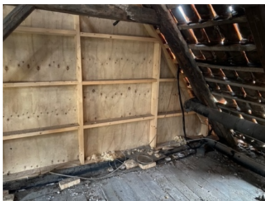
Loft på sidebygning mod allerede nedrevet gårdanlæg.
