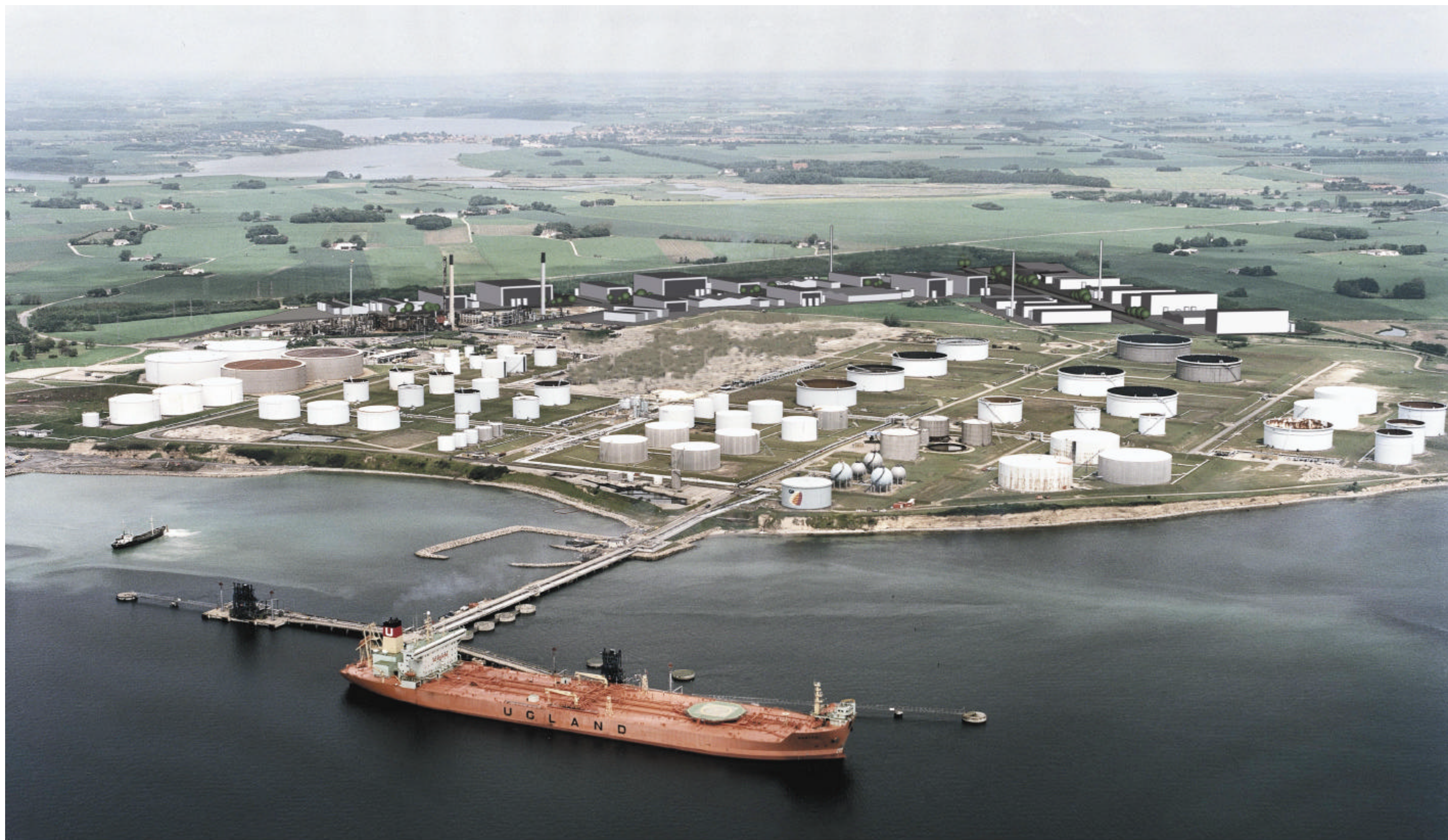
VIRKSOMHEDEN HALDOR TOPSØE A/S Set fra sydvest beliggende bagved de eksisterende tankanlæg på Stignæs
