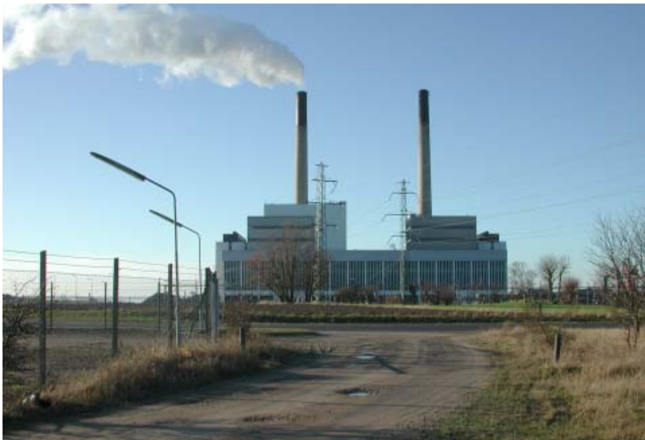
Her kommer den nye adgangsvej til lokalplanområdet fra Holtengårdsvej til at ligge. I baggrunden Stignæsværket.
