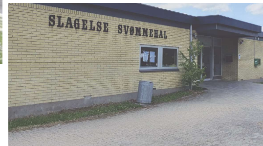
Eksisterende belægninger langs svømmehal
