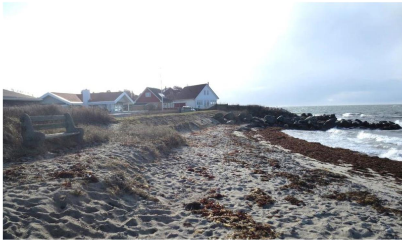
Område 1 (sydlige del af Delområde B) set mod syd hen mod pynten ved Pilevænget (Delområde C). Bemærk: læsideerosion og parallelværk ved flisebelægning lige nord for høfden.
