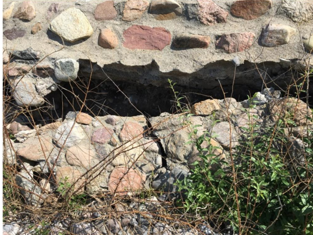
Figur 4-11. Reparation af eksisterende højvandsmur
