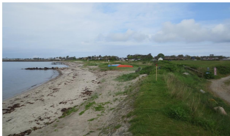
Område 1 set fra syd mod nord med eksisterende dige til højre
