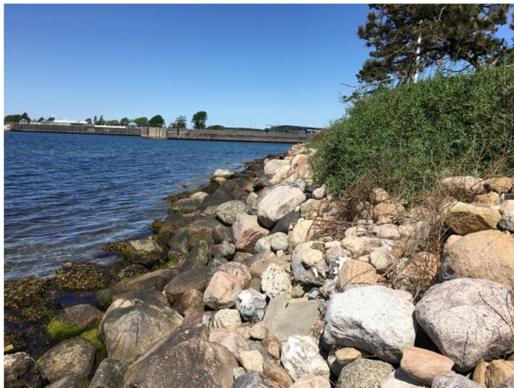
Figur 4-7. Skråningsbeskyttelse ved det nordligste og yderste hus
