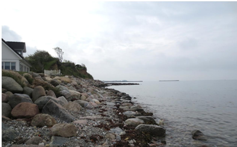
Delområde C set mod syd ved pynten hen mod klinten. Bemærk: den kraftige stenskråningsbeskyttelse.
