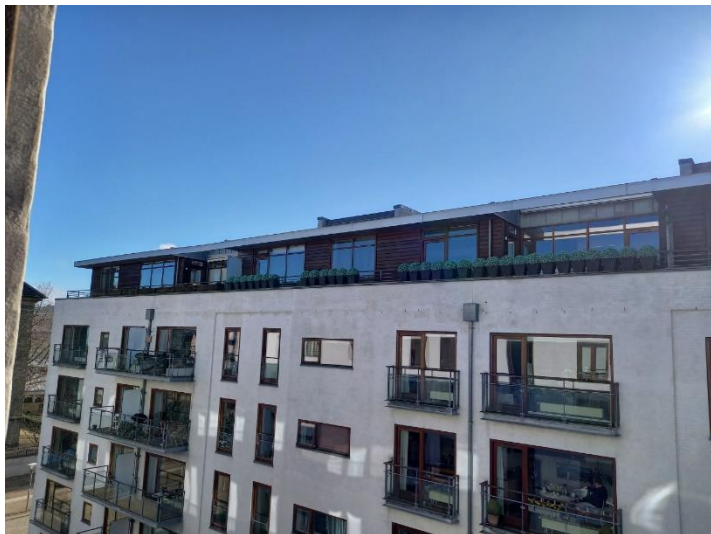
Eksempel på bebyggelse hvor øverste etage er trukket tilbage fra facaden på nedenstående etager.
