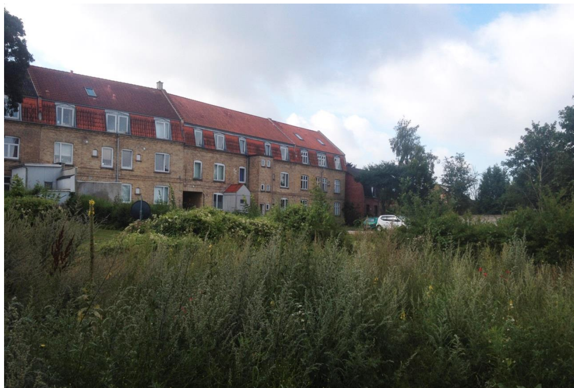
Sådan ser området ud i dag – set fra adgangsvejen via Oehlenschlägersgade
