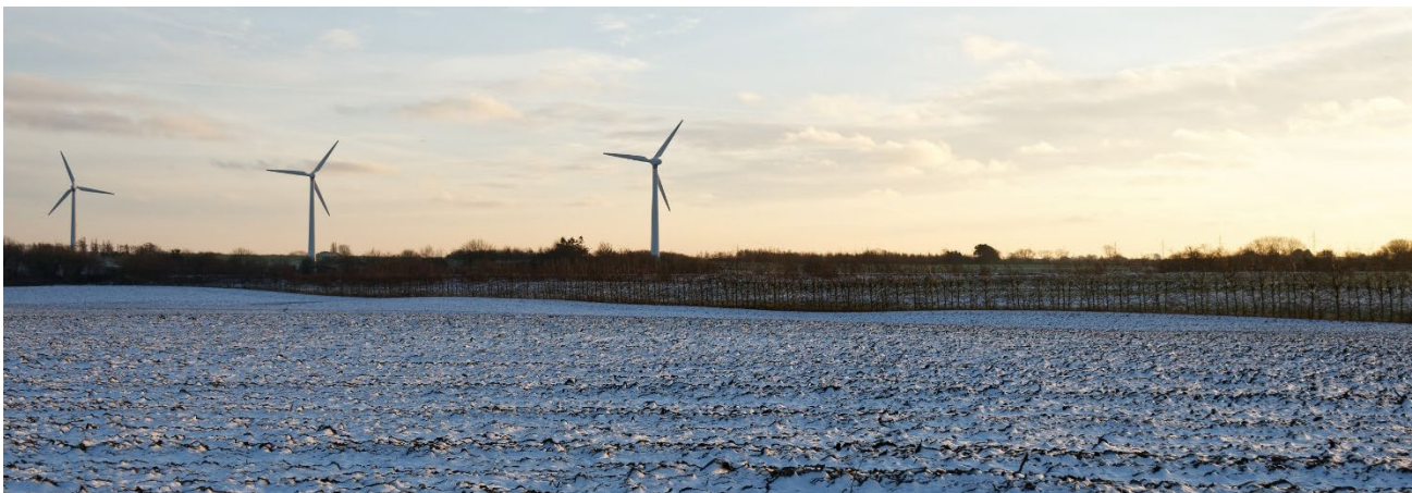
Figur 4-31 Visualiseringspunkt 4 – Eksisterende forhold. Udsigt fra Næstved Landevej – ca. 175 meter nord for plan- og projektområdet. Vindmøllerne i venstre side af billedet har en totalhøjde på 53 meter jf. vindinfo.dk.
