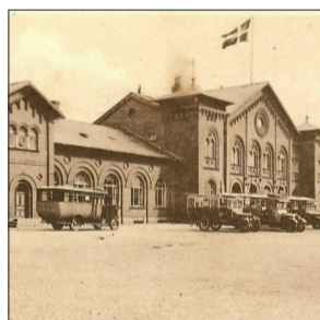
I starten af det 20. aarh. - Shared space og chaussésten fra facade til facade.
