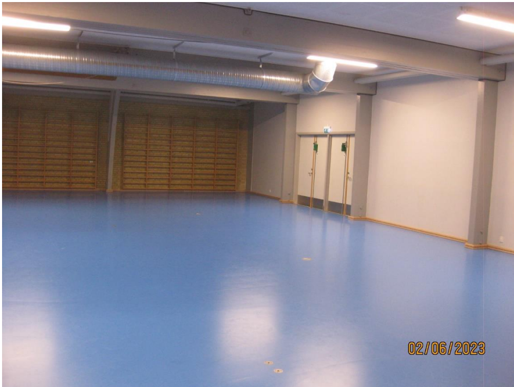
Gymnastiksal med dårlig akustik
