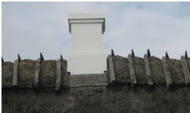
Eksempel på skorsten i en stråtækt ejendom
