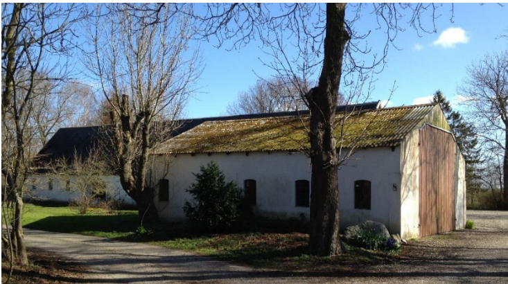
Udhus med lav taghældning (Smedevej 8).
