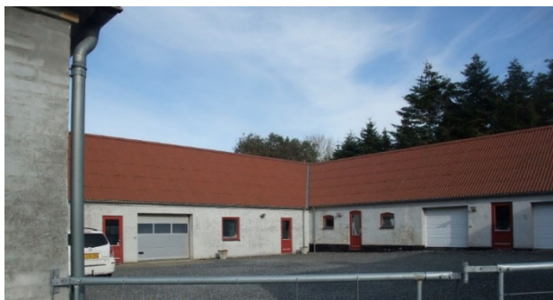
Tværgaards eksisterende nord og øst længe
