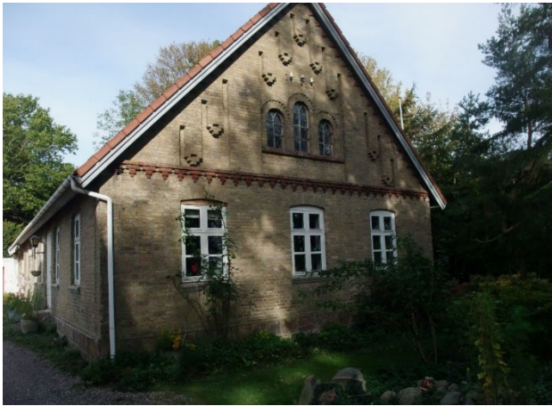
Pilevangsgaards gavl på stuehus
