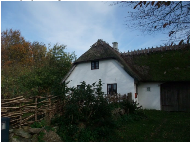
Aagårds beboelse- og tidl. driftsbygning er sammenbygget
