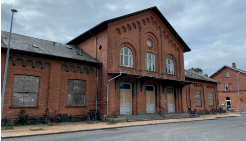
Stationsbygningen har ikke været i anvendelse som station siden 1950.
