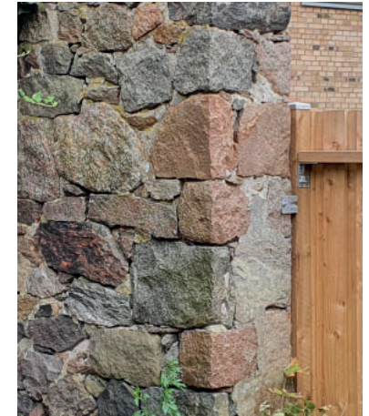
Kampestensmuren ved Jernbanevej er formodentlig en sidste rest af et befæstet porttårn, som er omtalt i skriftlige kilder fra 1400-tallet. Skælskør har aldrig haft en egentlig bymur.
