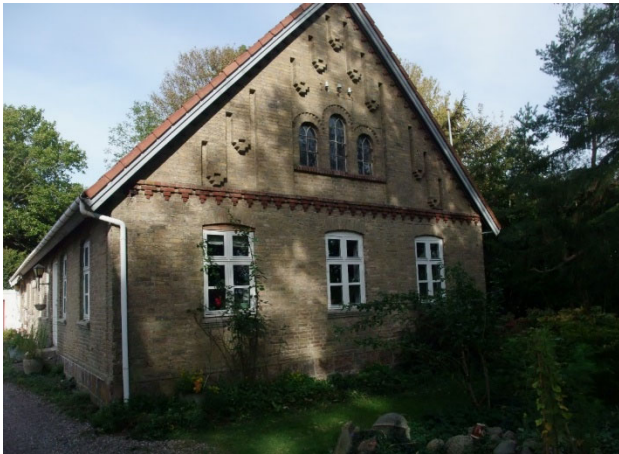
Pilevangsgaards gavl på stuehus
