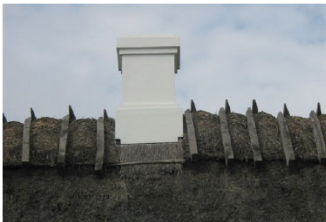
Eksempel på skorsten i en stråtækt ejendom
