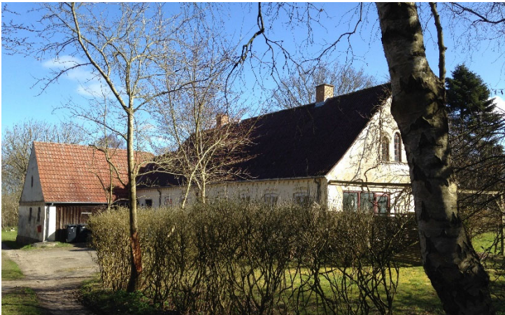
Beboelsesbygningen Smedevej 5 har symmetrisk sadeltag med en hældning på ca. 45°.
