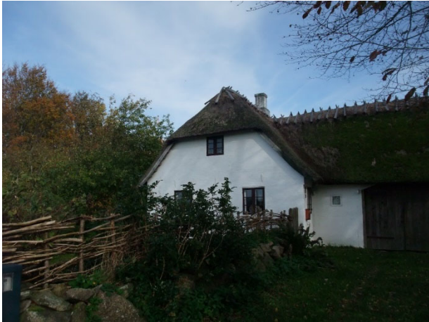
Aagårds beboelse- og tidl. driftsbygning er sammenbygget
