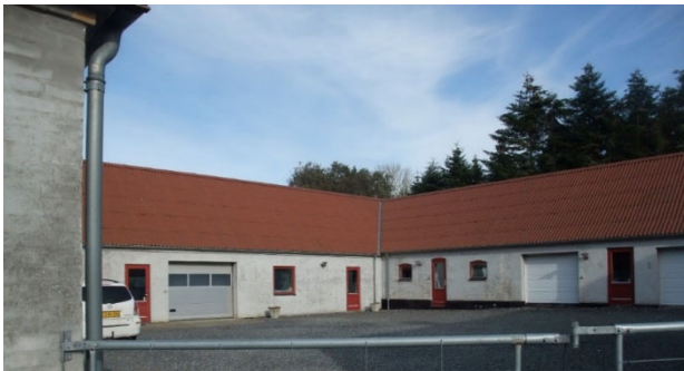
Tværgaards eksisterende nord og øst længe
