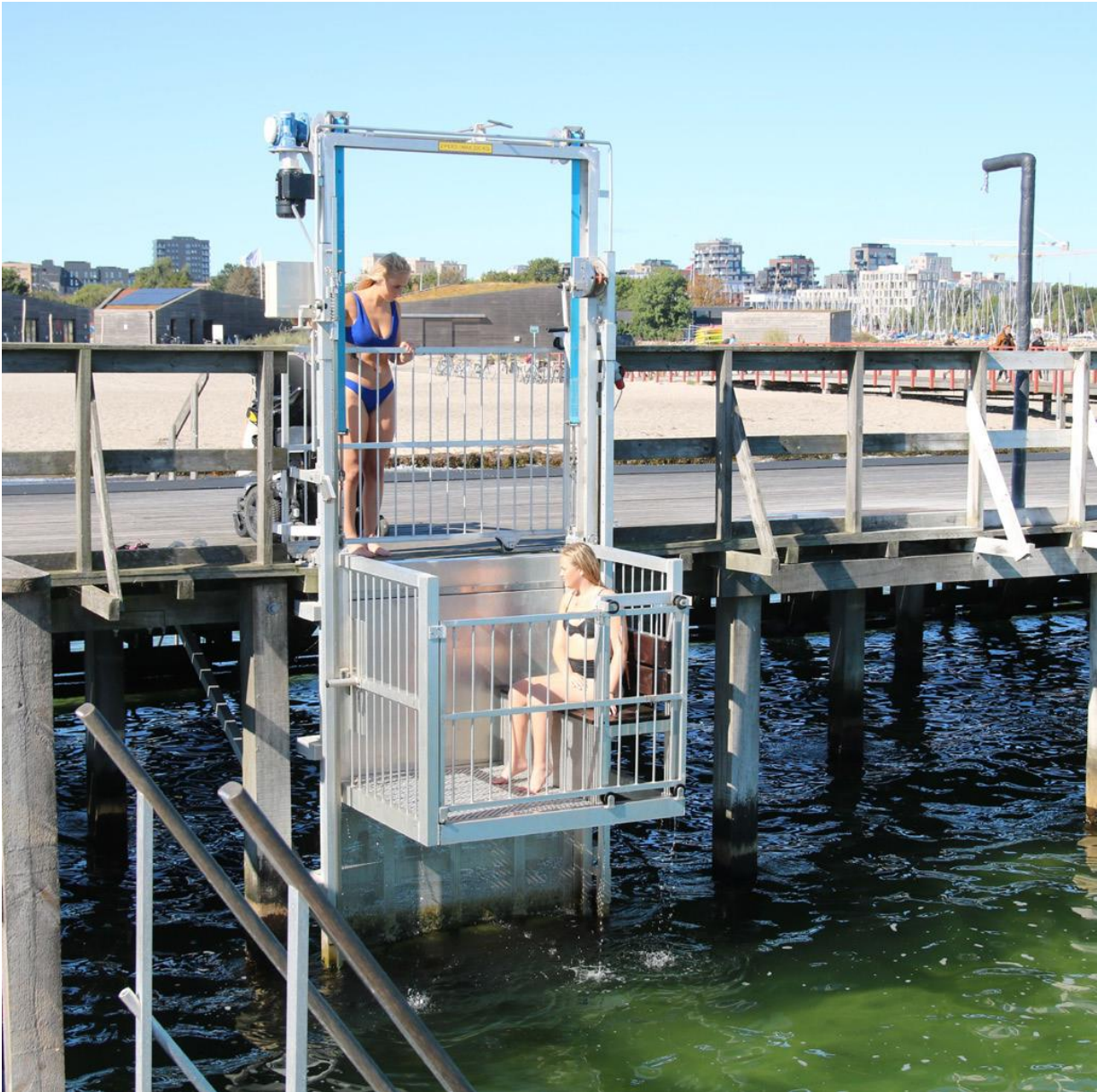
Figur 1: Handicapliften som monteres på sydsiden af badebroen. Liften skal aktiveres med SMS for at gøre det mindre attraktivt for eksempelvis unge mennesker at benytte den som legeredskab. I vinterhalvåret tages liften på land, for at sikre den mod vinterstorme.
