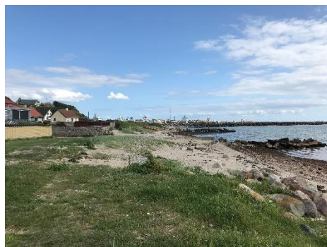
3. Fra skråningsbeskyttelse mod havnemole SØ
