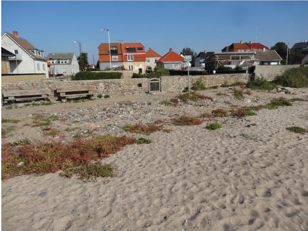
Billede 7: Bølgedæmpende stabil strand med højvandsmur i skel og promenade foran (16. september 2014).
