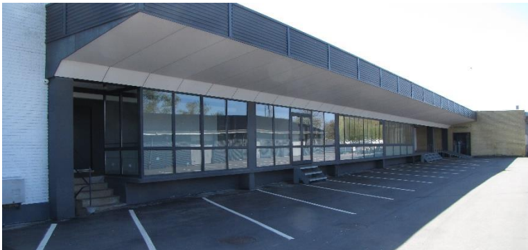
Bagvedliggende del af bygningen med facade mod det eksisterende parkeringsareal med adgang fra Landsgravvej.
