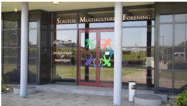
Eksisterende skiltning på facaden ved indgangspartiet.
