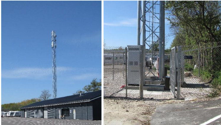
Eksisterende telemast placeret op mod den nordøstlige afgrænsning af lokalplanområdet med serviceadgang fra lokalplanområdet.
