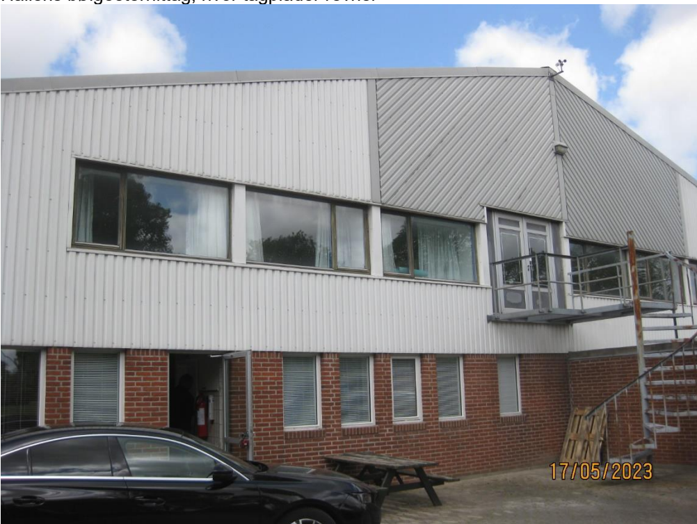
Ældre vinduer på 1.sal (Multirum mm.)
