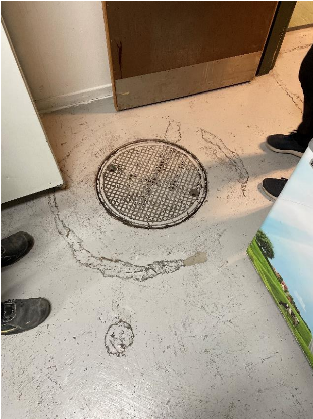
Pumpebrønde som bør forsynes med alarm
