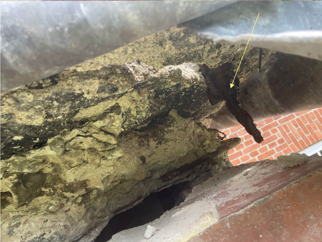
3Hjørne set nedefra, underbetonddæk. Blyinddækning er bøjet op.
