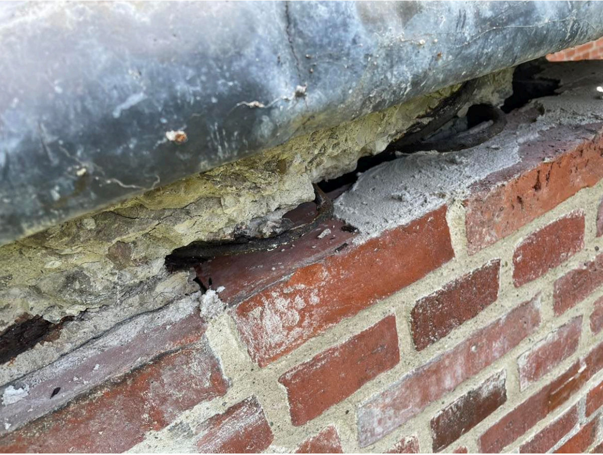
4 Armeringens forfatning, set fra langside, front
