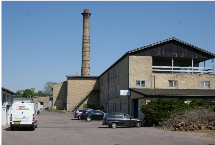
Bygninger i delområde 1
