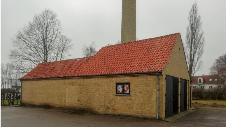
Den bevaringsværdige bygning set fra sydsiden
