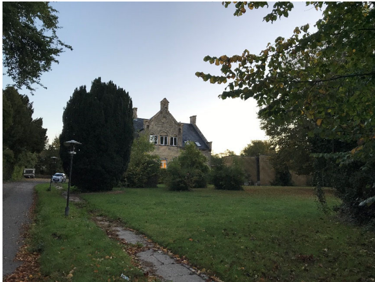
Skælskør tidligere bibliotek er i dag indrettet med flere lejligheder. Bygningen og dens baghus har høj bevaringsværdi.
