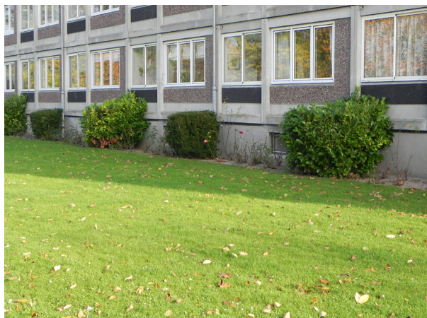
Området foran bygningen omlægges
