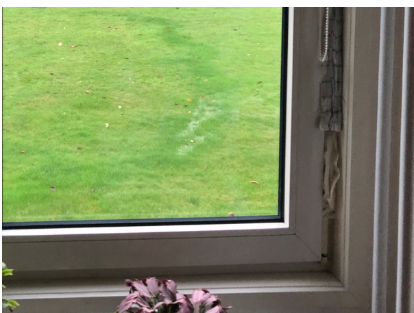
Utæt vindueselement, hvor det trækker voldsomt ind. Restlevetiden er begrænset da vinduerne er udgået af produktion.
