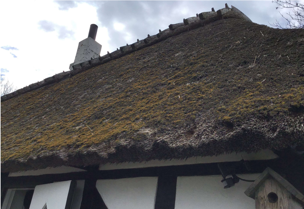
Klintegårdens tyndslidte tag med valm
