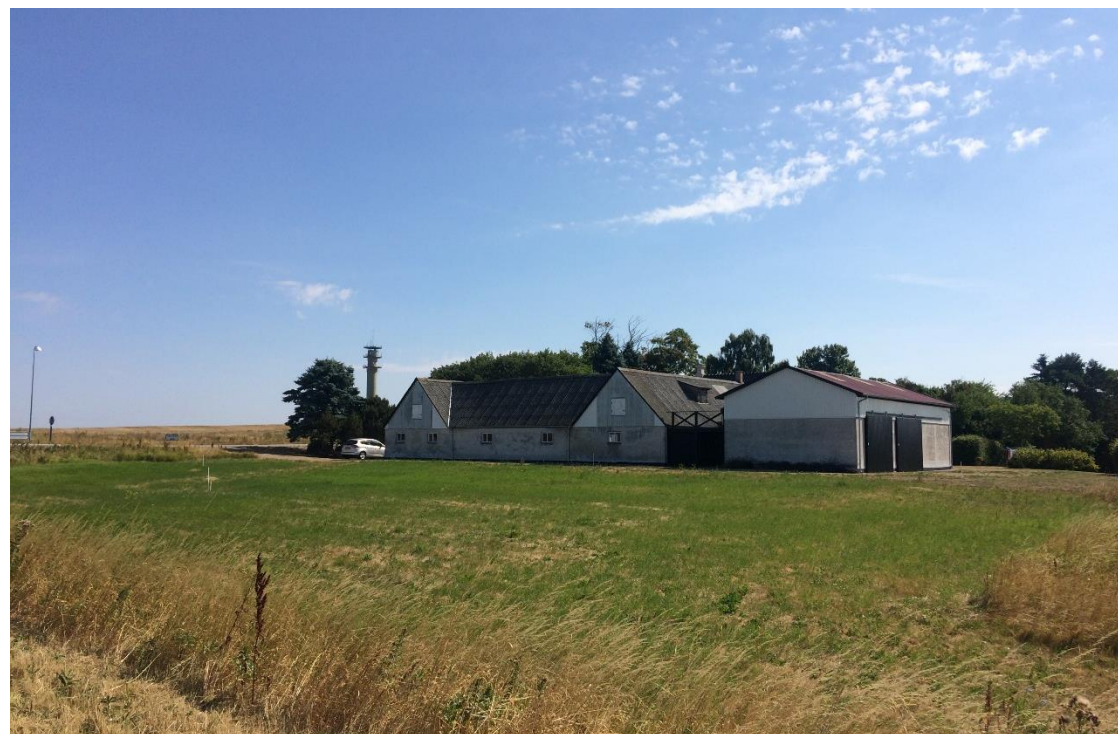
Lokalplanområdet set fra vest på Skælskør Landevej.
