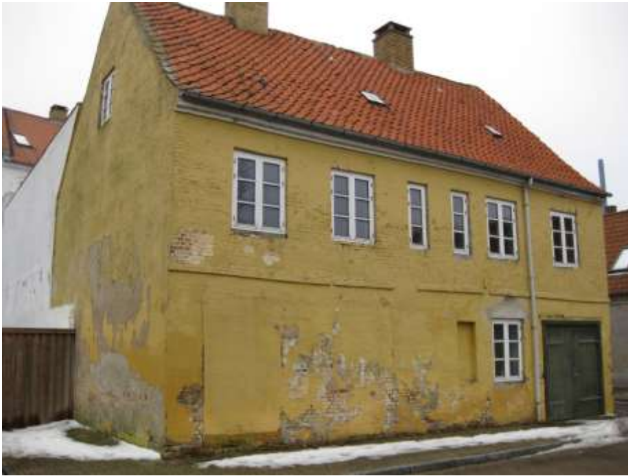
Ejendommen set fra City-parkeringen.
