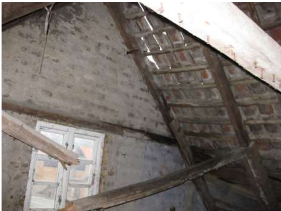
Tagetagen af bygningen.
