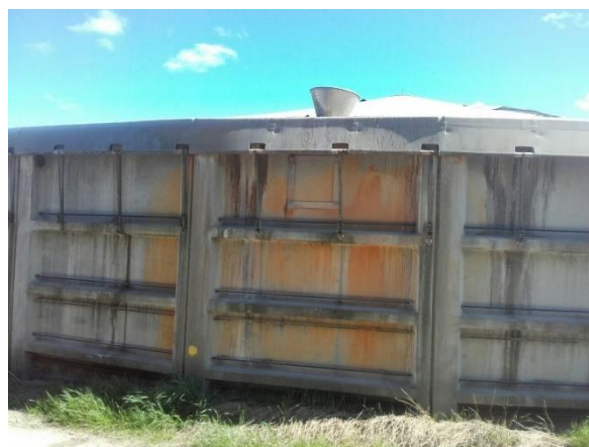
Biogasanlæggets produktion (afsug, luftren-
