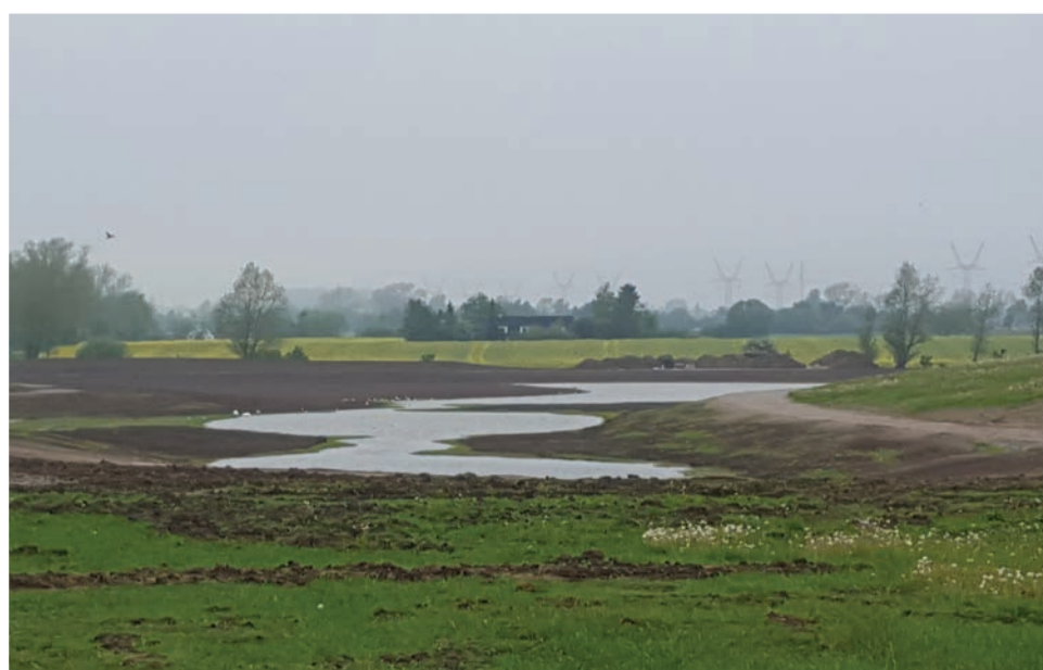
Nyanlagt regnvandsbassin / sø TIDSELBJERGET SLAGELSE
