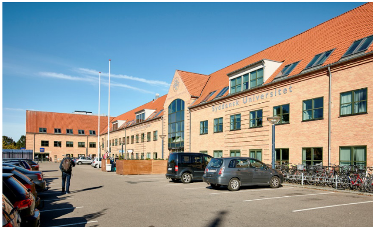
Perron 1-bygningens facade mod Sdr. Stationsvej.
