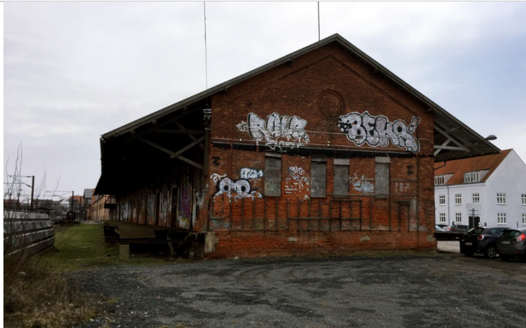
Godsbanebygningens vestgavl som den står i dag.
