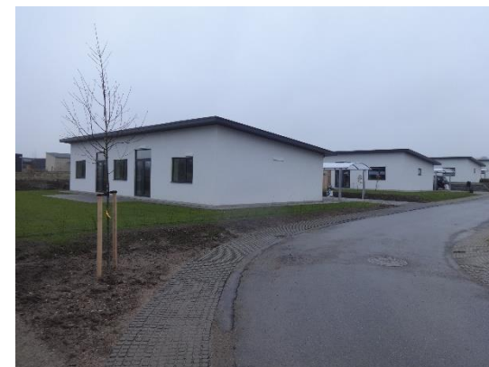
Første etape af Rosenhaven på Tidselbjerget er etableret i 2017 og 2018.
