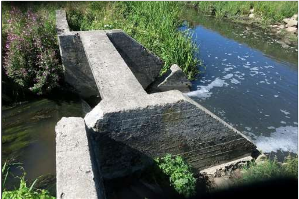
Figur 2-5 Betonbygværket, der udgør spærringen.
