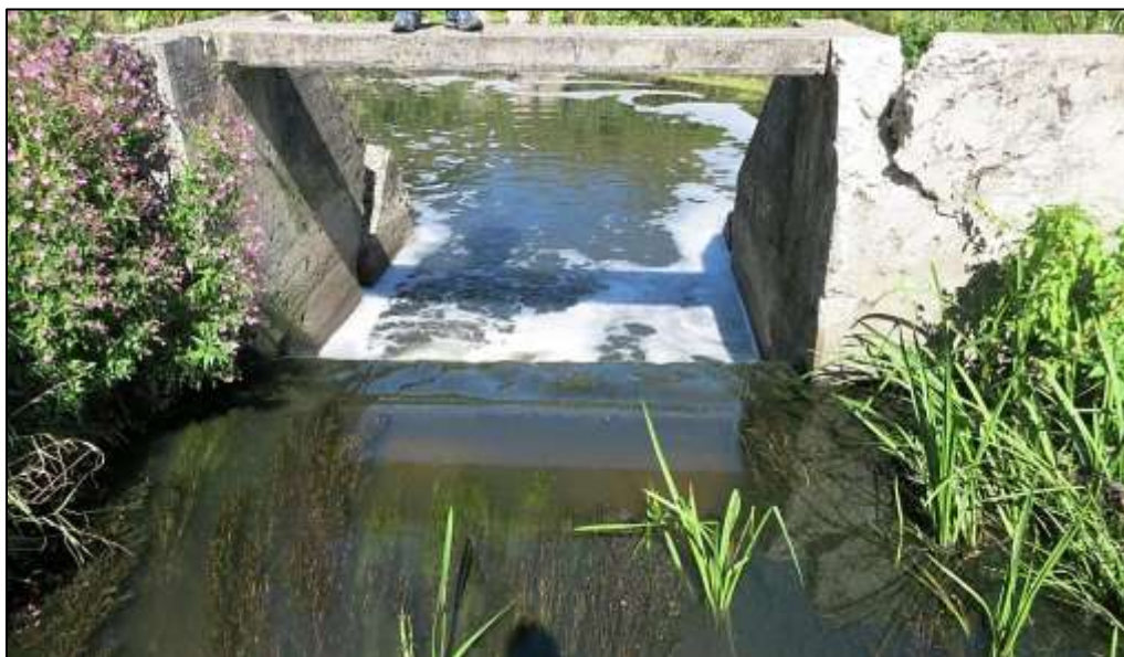
Figur 2-3 Betonbygværket der udgør spærring nr. NYK-239. I baggrunden ses Tude Å.
