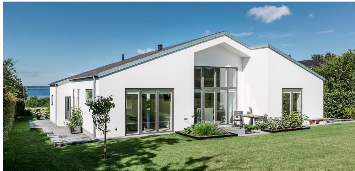
Hus med saddeltag med taghældning på 30 grader bygget i moderne stil. Fotokilde: www.skanlux.dk
