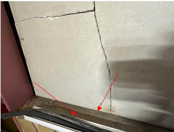
#15 Vægplade med brud og brudstykker/fragmenter på overside af murværk
