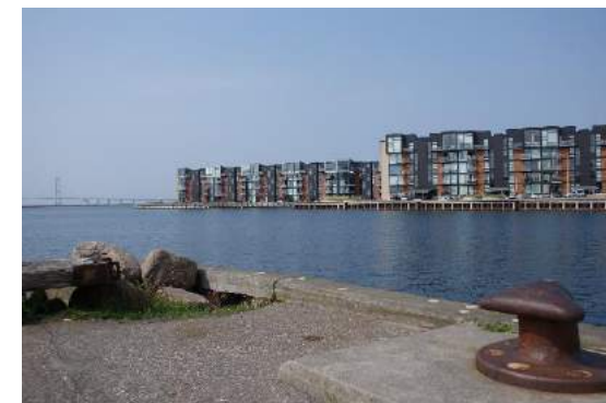
Ved Pierne i Korsør er der mulighed for at etablere flere boliger.
