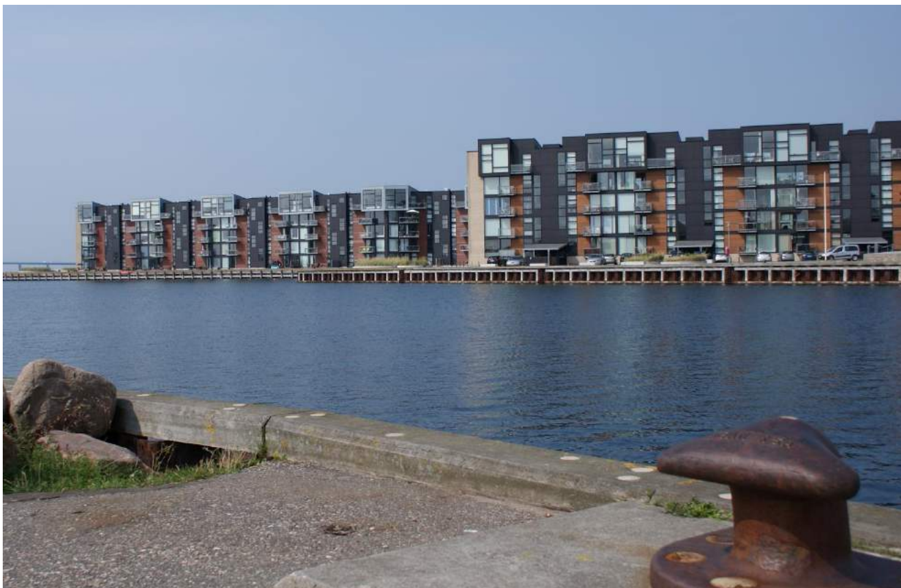
Pierne forventes udbygget med flere etageboliger inden for de kommende år.
