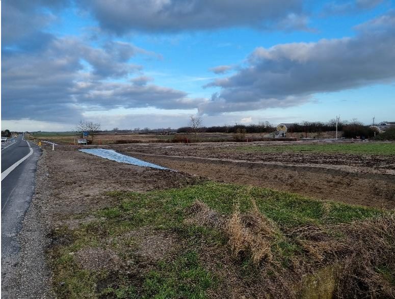
Området set fra vest, fra Slagelse Landevej. Billedet viser indkig til bygværk på rensningsanlægget.
