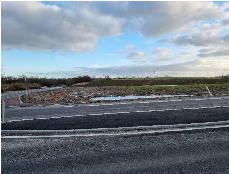
Billedet viser området set fra Slagelse Landevej ved Genbrugsvej.
