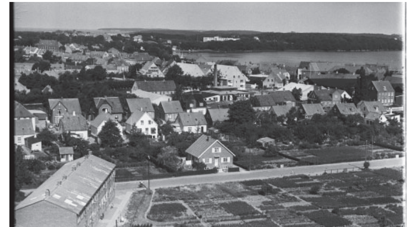
Carl Medingsvej- husene set fra havensiden, altså fra øst ca. 1957. I forgrunden kolonihaver, som gav småkårsfolk i. f.eks. lejligheder et vigtigt tilskud til maden. I baggrunden ses de nye store boligblokke, men også flere af de gamle industribygninger. Luftfoto fra Det Kongelige bibliotek
