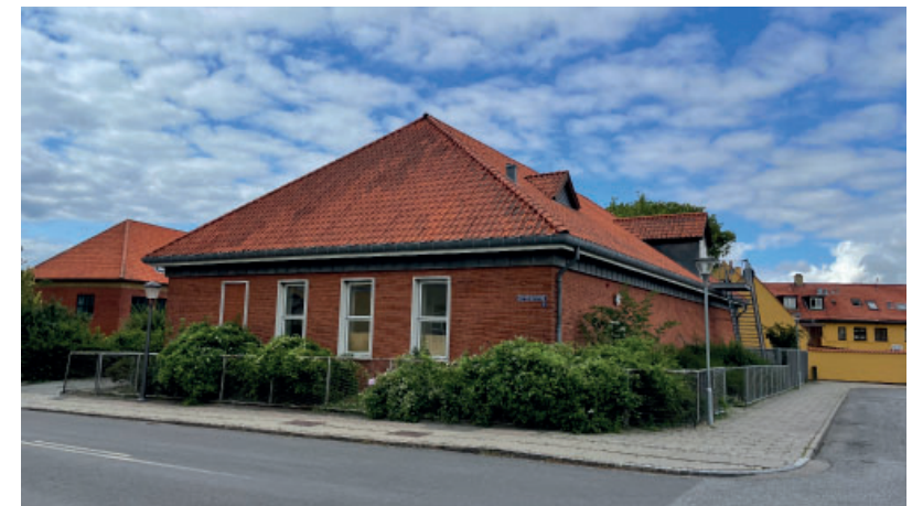
KTAS telefonhus fra 1963 er en typisk pladsudfyldning i det tidligere industriområde. Her lå tidligere dele af spritfabrikken, der blev nedrevet i 1954
