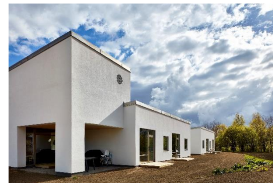
Der er etableret 25 nye plejeboliger ved Rosenkildevej i Slagelse i 2017, som en del af Autisme Center Vestsjælland.
