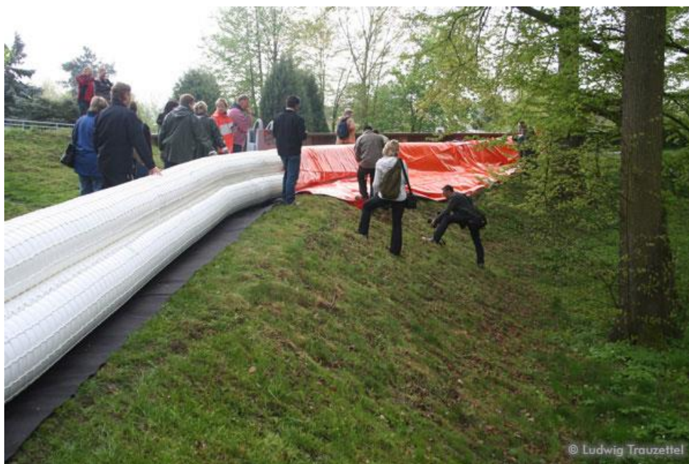
Vandfyldt mobil dæmning (watertube)
